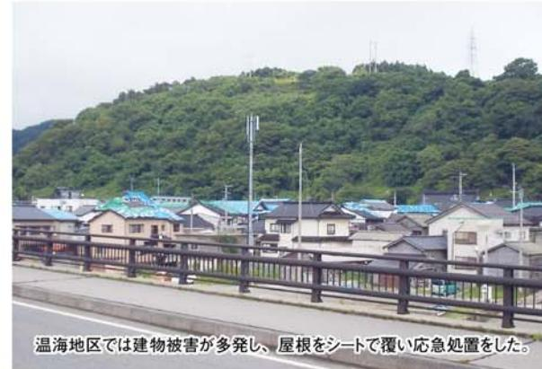
温海地区では建物被害が多発し、屋根をシートで覆い応急処置をした。
