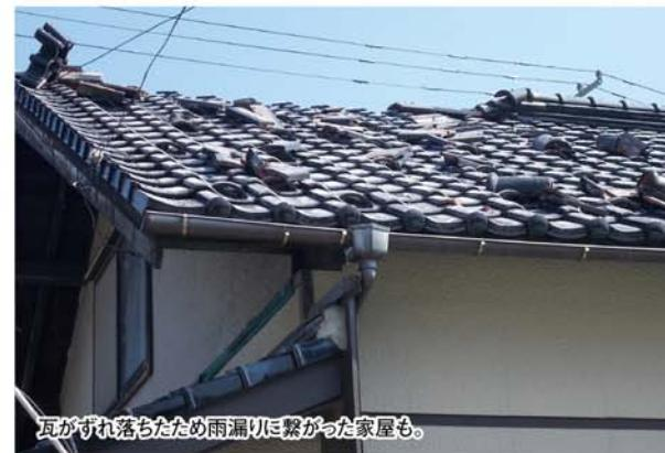
瓦がずれ落ちたため雨漏りに繋がった家屋も。
