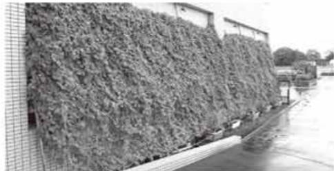
写真1. グリーンカーテンの使用例
