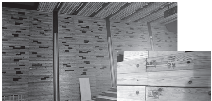
図3. 大講義室の施工状況
