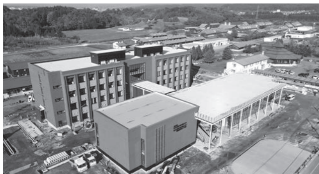
図2. 完成間近の新校舎(令和5年10月30日現在)
