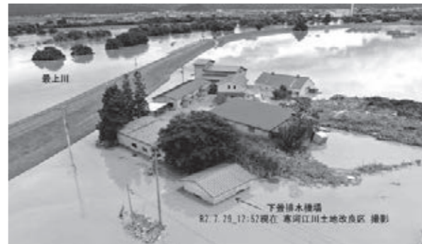
令和2年7月豪雨における排水機場の浸水状況（河北町）
